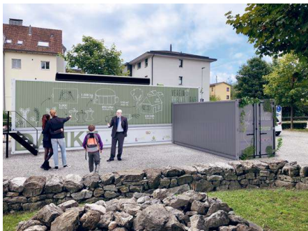
→ Nach einer Fotomontage, aber schon bald in Triesen in Betrieb: eine kompakte Biogasanlage für Abfälle aus der Gastronomie, die für Fernwärme und hochwertigen Dünger sorgen wird.
